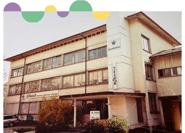
Die alte Tagesstätte im I. Stock der ehemaligen Uhren-Fabrik
